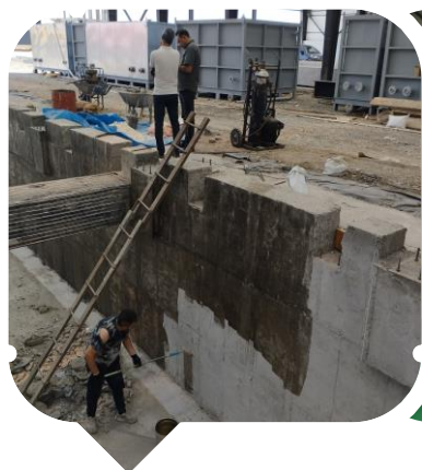
اجرای دیواره بتنی و رنگ آمیزی
